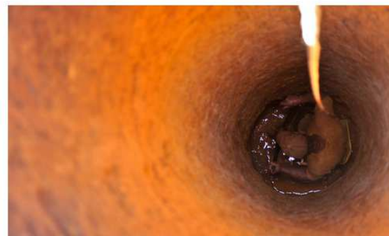
Trabalhador rebaixa poço na zona rural
